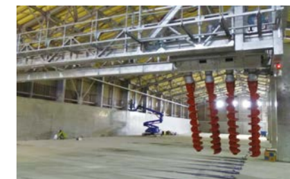
山形県・搾乳堆肥舎
